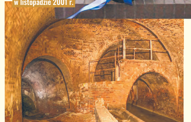
Drugie prawdziwe miasto z cegły znajduje się pod ziemią. Łódź posiada ponad 250 km murowanych kolektorów o różnych wielkościach i przekrojach (40 rodzajów) w kształcie dzwonu, gruszki, jaja. Największą i najciekawszą pod względem konstrukcji jest komora przelewu burzowego do Karolewki, mieszcząca się pod ulicą Pienistą przy ul. Obywatelskiej. Jej ogromna kubatura (ponad 5 m wysokości) i łukowate sklepienia upodabniają ją do podziemi średniowiecznych warowni.
