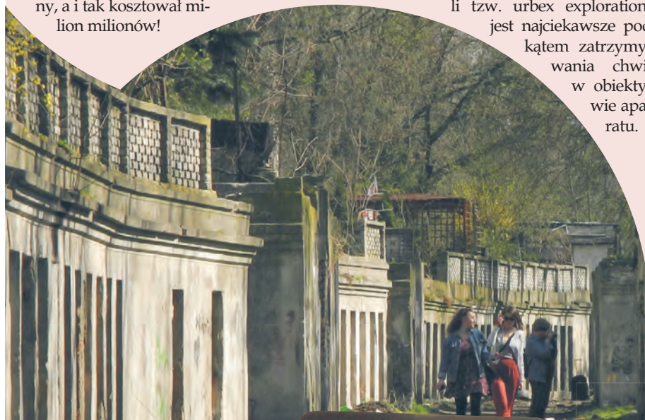
Katakumby Abramowskiego przed remontem
