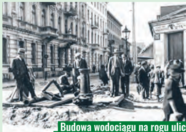
Budowa wodociągu na rogu ulic Zielonej i Żeromskiego w 1934 r.
