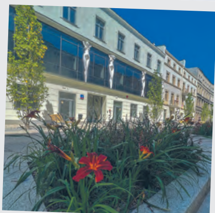
Kamienice na Włókienniczej
