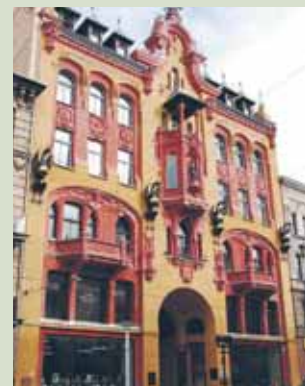
Kamienica Pod Gutenbergiem
