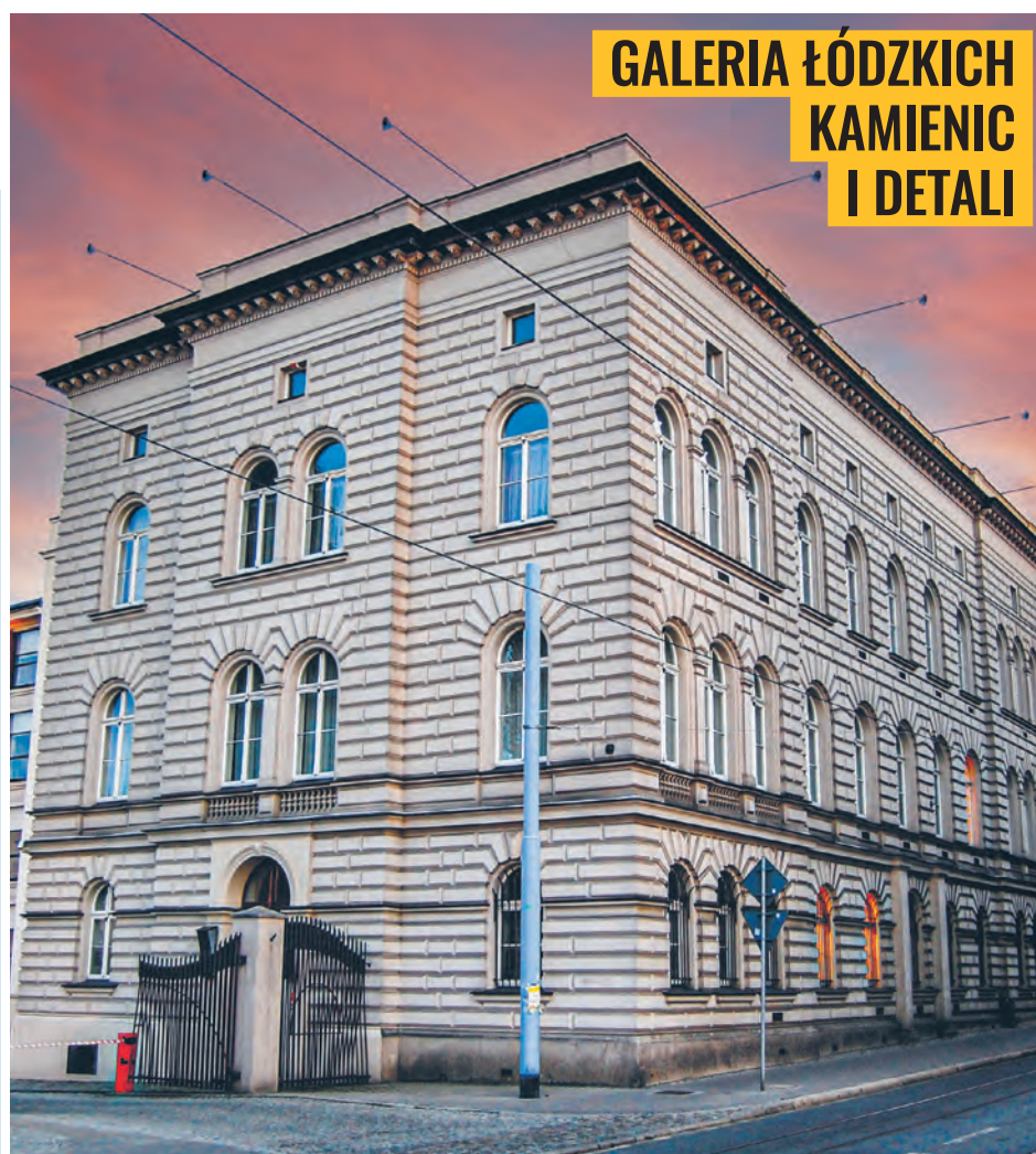
Pałac Roberta Biedermanna znajdujący się przy ul. Kilińskiego 2, zbudowany w latach 1878–1879, zaprojektowany prawdopodobnie przez architekta Hilarego Majewskiego
