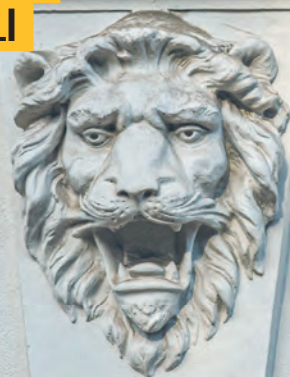
Detal architektoniczny na kamienicy przy ul. Kilińskiego 86 z 1897 r.
