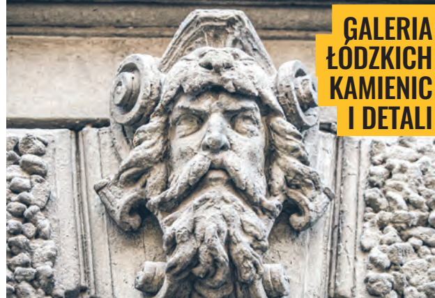
Detal architektoniczny na kamienicy przy ul. Próchnika 10
