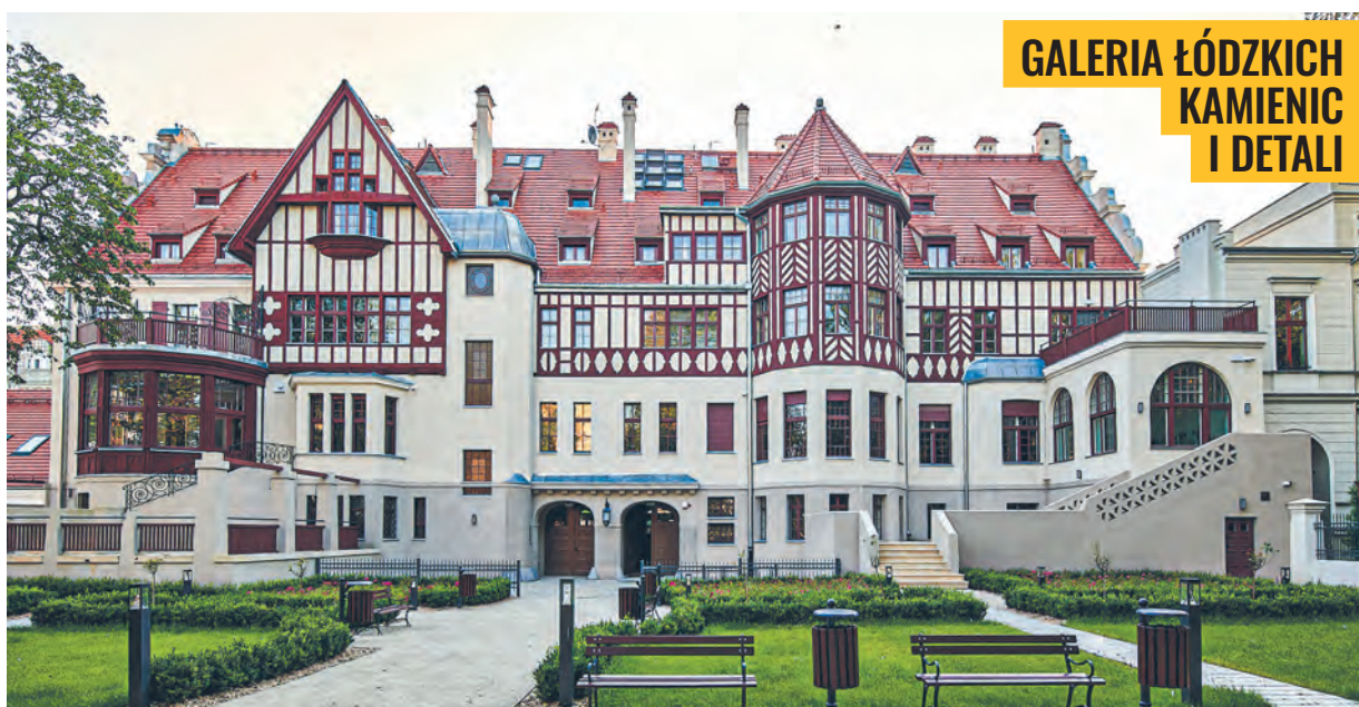
Pałac braci Steinertów, synów Adolfa, przy ul. Piotrkowskiej 272, zbudowany w latach 1909–1911 wg projektu berlińskiego architekta Alfreda Balckego w stylu nawiązującym do renesansu północnoniemieckiego
