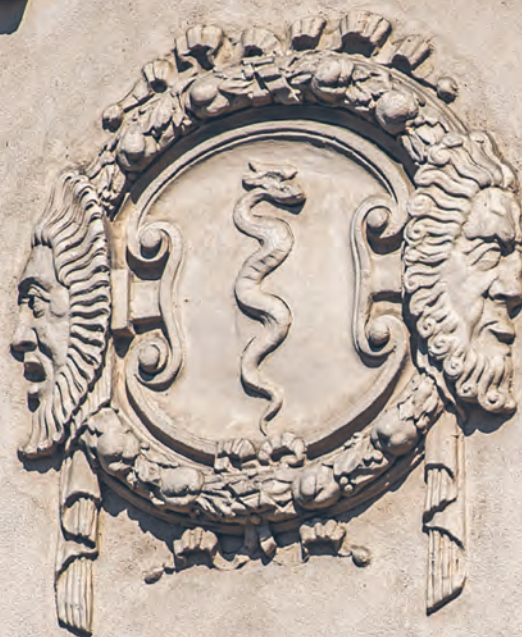
Detal architektoniczny budynku dawnego hotelu Polonia Residence przy ul. Narutowicza 38, zbudowanego w latach 1910–1912 przez rodzinę Dobrzyńskich
