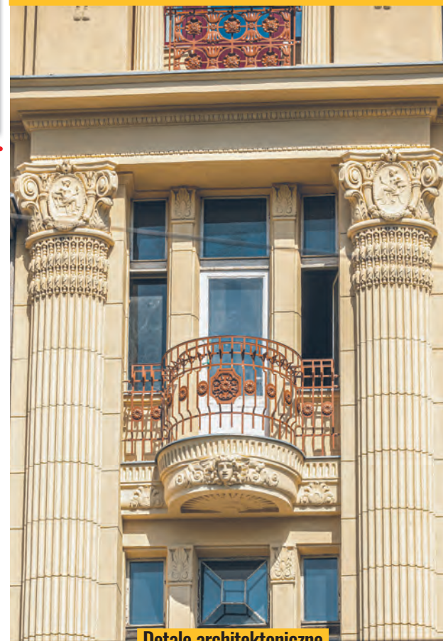
Detale architektoniczne kamienicy w stylu zmodernizowanego klasycyzmu, zbudowanej w 1910 r. dla Mendla Lejba Briska przy ul. Narutowicza 42 wg projektu Dawida Landego
