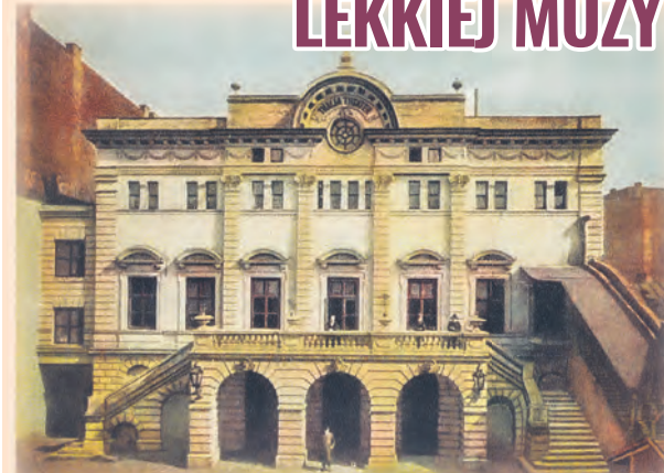
Budynek niemieckiego Teatru Thalia przy ul. Dzielnej
