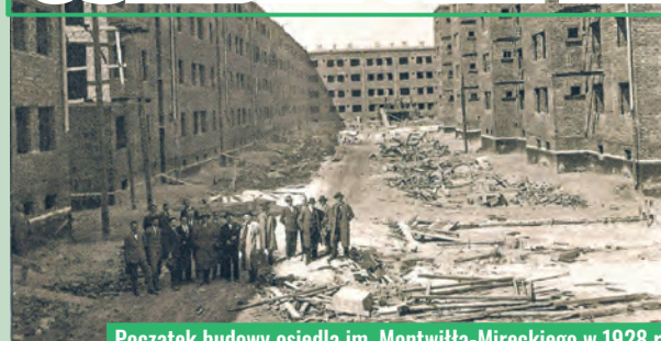
Początek budowy osiedla im. Montwiłła-Mireckiego w 1928 r.
