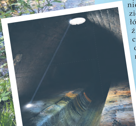
Kanał rzeki Łódki zasilany jest wodami gruntowymi
