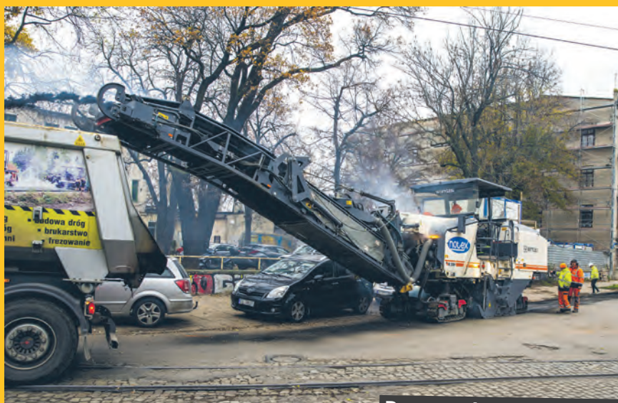
Remont ul. Mielczarskiego
